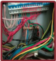
(图为配电设备接线不规范，零线串接)
